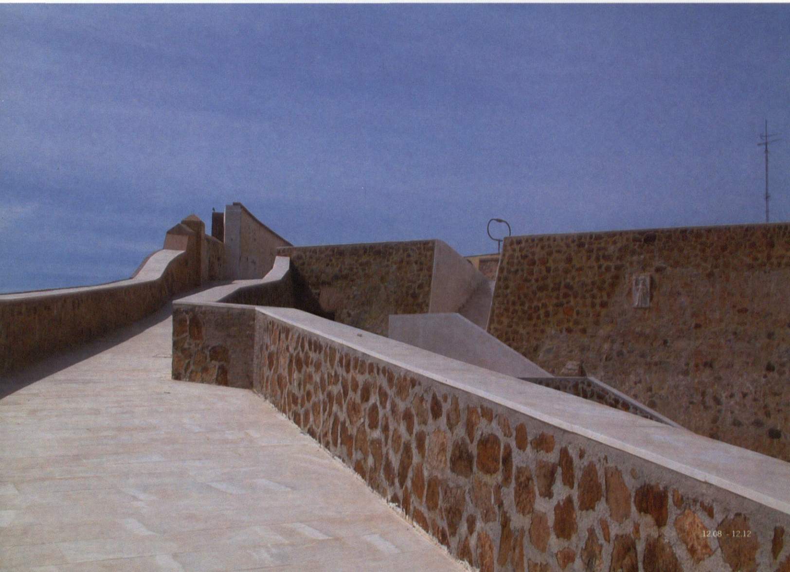
12- DETALLE DE LA RECONSTRUCCIÓN DE LA MAMPOSTERÍA DE LAS MURALLAS
